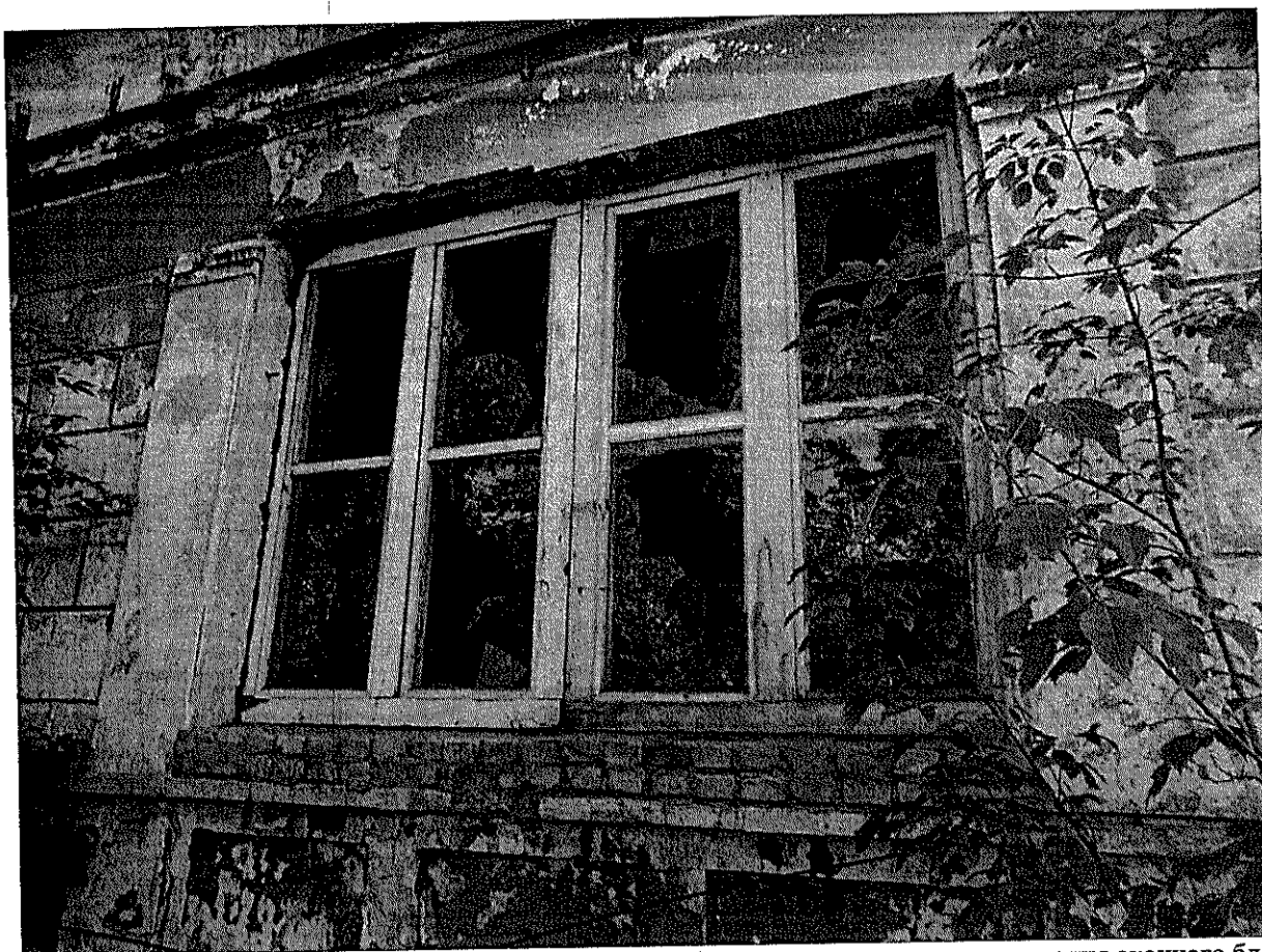
Фото 3 от 18.08.2021. Фрагмент юго-западного фасада. Нарушение целостности остекления оконного блока, повреждение отделочного слоя фасада.
